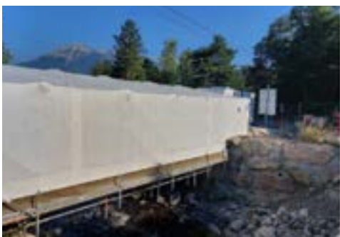
Confinement pour le décapage de la peinture au plomb, et application nouvelle peinture
